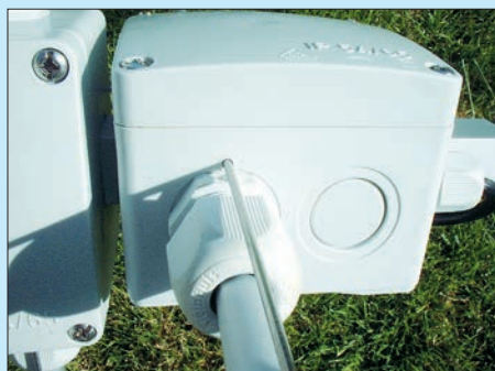
Bild 17: Einführung der Phasenleitung in die Abzweigdose
