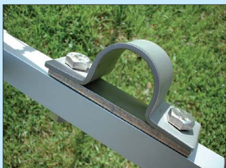
Bild 3: Befestigungsschelle und Verstärkungsblech am Antennenträger
